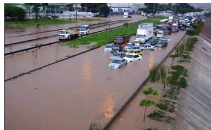
Foto 4 – Prejuízos causados pelas Cheias
